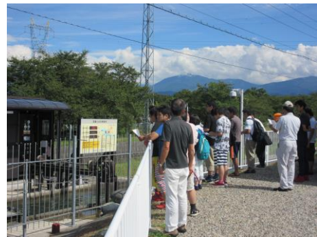
西番小水力発電所
