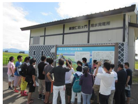
仁右エ門小水力発電所
