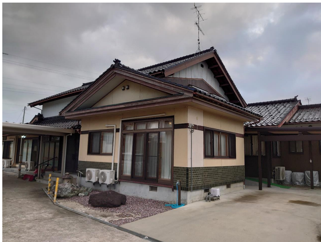
調査対象施設の外観
