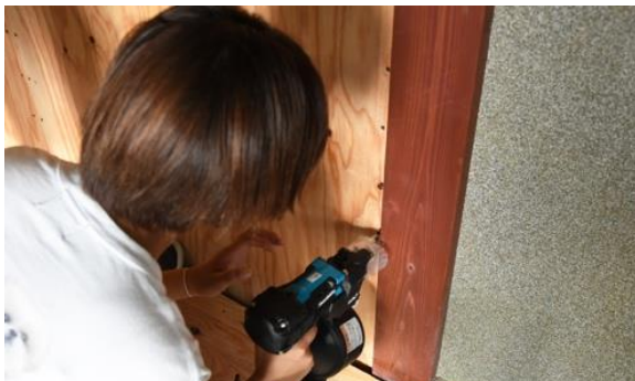
図 5 釘打ち機で釘を打つ様子
